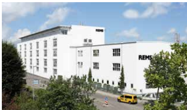
REMS centro di formazione a Waiblingen vicino a Stoccarda.
